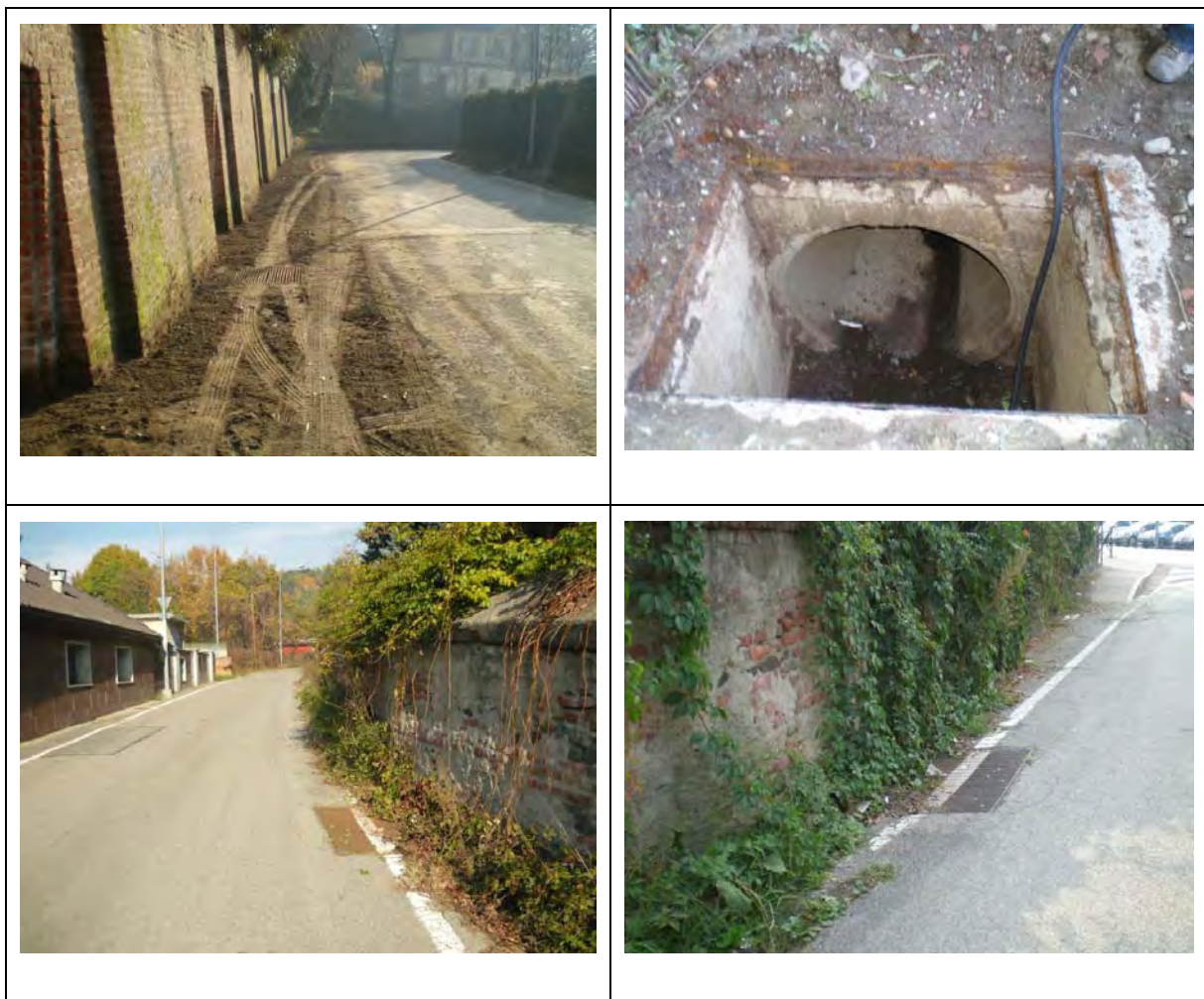
Figura 3 – Rio tombato sotto la banchina di strada Cigala – caditoie a griglia esistenti
