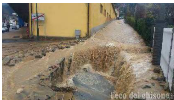
Perosa Argentina - Sprofondamento di una strada al confine con la frazione Castelnuovo di Pinasca
