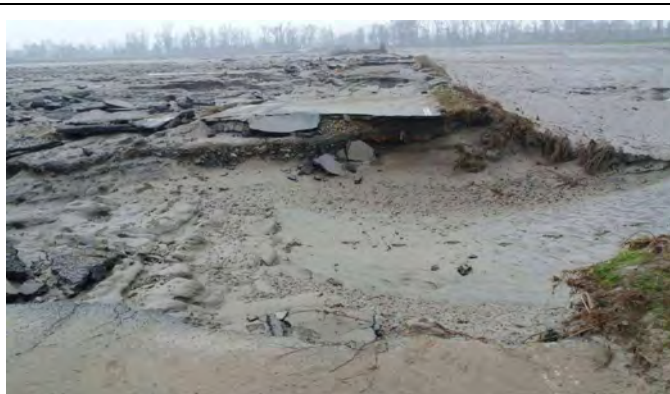
Pancalieri - S.P. 149 – Asportazione del corpo stradale per esondazione del fiume Po
