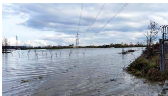
Moncalieri – acque di esondazione provenienti dalla rottura dell'argine del T. Chisola
