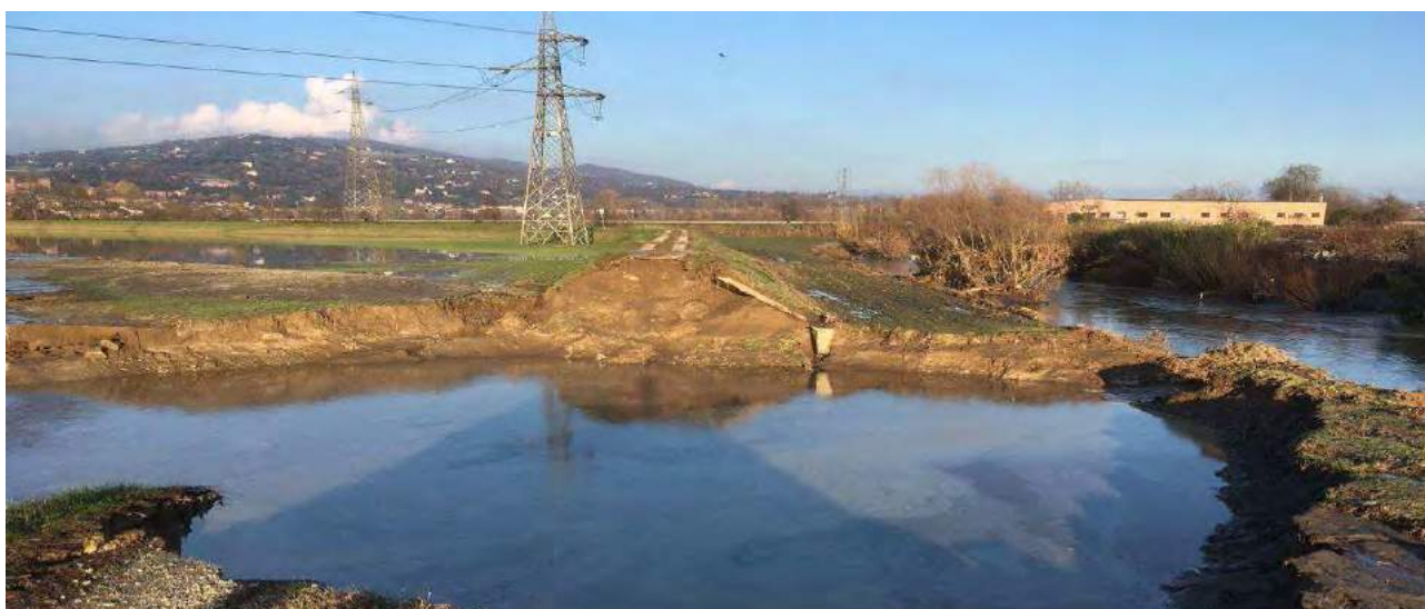
Moncalieri (TO) 26 Novembre 2016: operazioni di soccorso (in alto - foto tratte da fonte web, "LaStampa" e "InMeteo"); area di Moncalieri alluvionata (in centro - foto tratte da fonte web, "LaStampa"); rottura arginale in corrispondenza del Torrente Chisola in prossimità della confluenza col Fiume Po (in basso - Foto di Fabio Luino, CNR IRPI)
