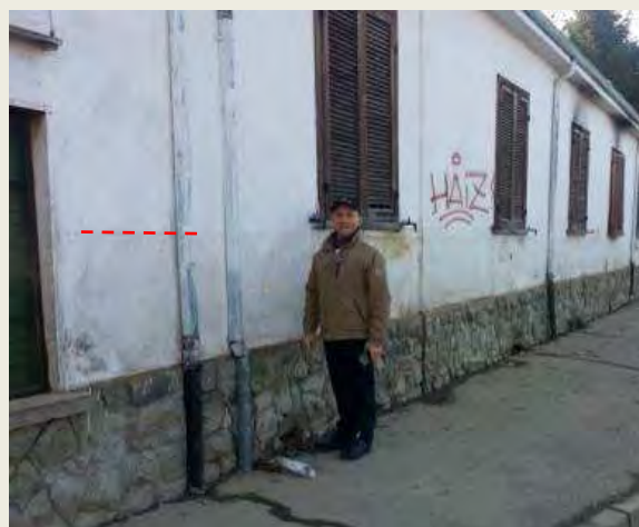
Tracce delle altezze idrometriche sui muri delle abitazioni (circa 1,5 m sul piano campagna)
