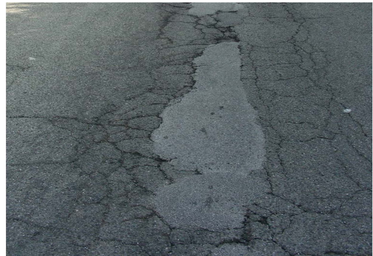
FOTO 3 – 4 : Stato di fatto – Dettagli del manto stradale a centro carreggiata
