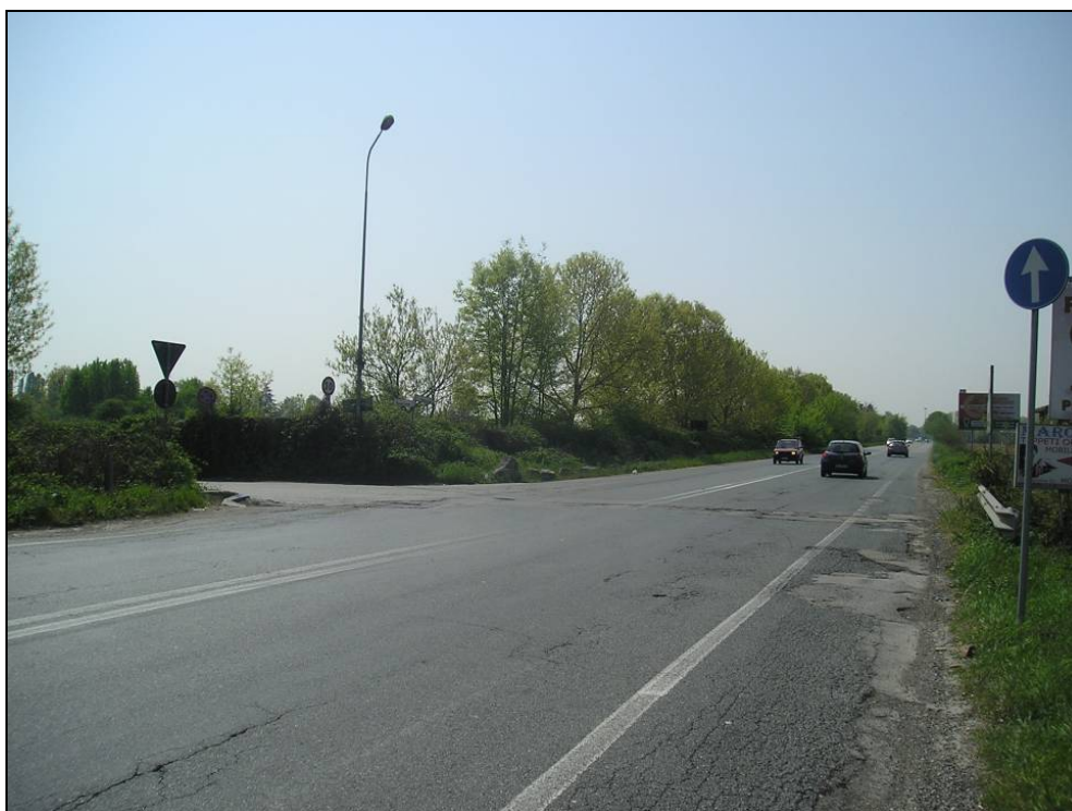
Figura 4.2/4 - Via Debouché, in corrispondenza dell'innesto di via Debouché
