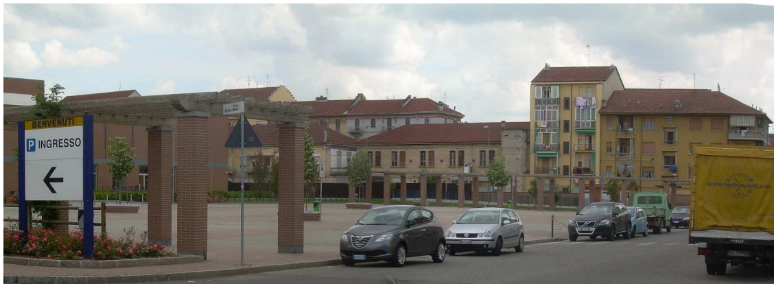
Foto 3.2.8/III – Vista dell'area pedonale a sud di ESSELUNGA. Sullo sfondo sono visibili i due edifici di cui il PEC prevede la demolizione
