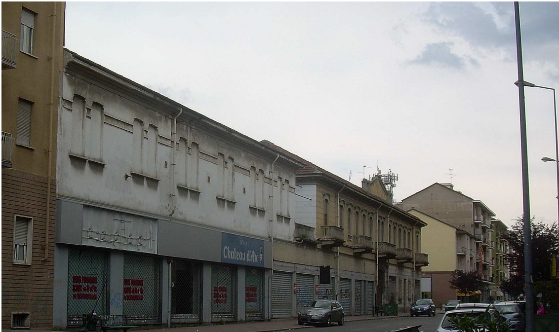
Foto 3.2.4/II Vista del fronte verso strada dei due edifici di cui si prevede la demolizione
