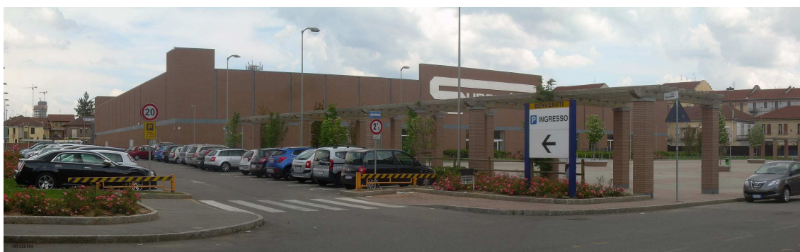
Foto 3.2.8/II – Vista del parcheggio parallelo a Via Somalia e dello spazio pedonale a sud di ESSELUNGA
