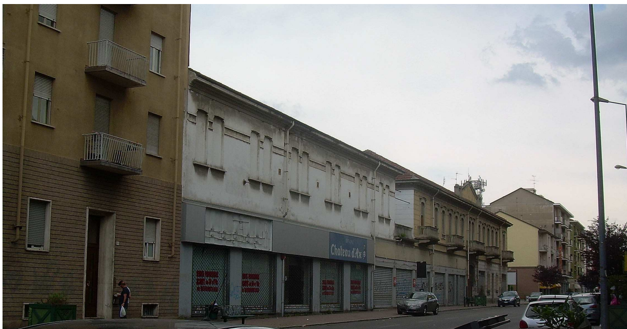
Foto 2.3/II – Situazione attuale del fronte lungo Via Sestriere
