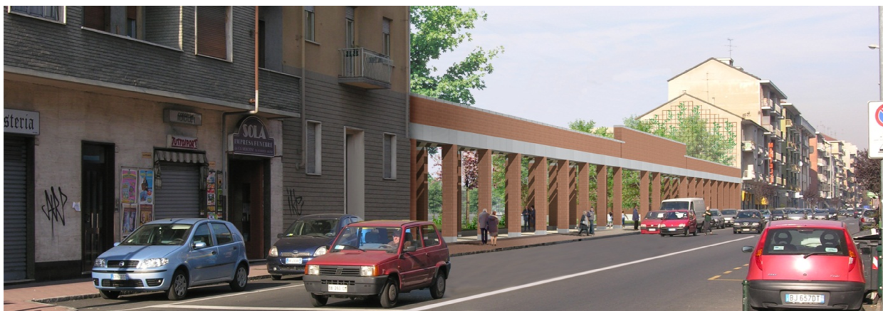
Foto 2.3/I - Sistemazione del fronte lungo Via Sestriere
