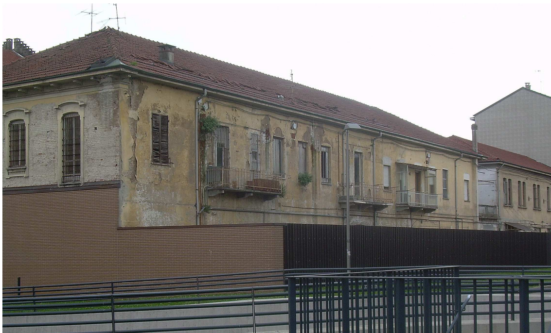
Foto 3.2.4/I Vista del fronte interno dei due edifici di cui si prevede la demolizione
