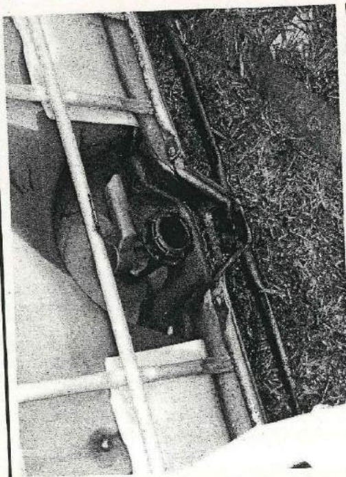
Foto 5: rubinetto della cisterna con evidenti tracce di fuoriuscite di gasolio
