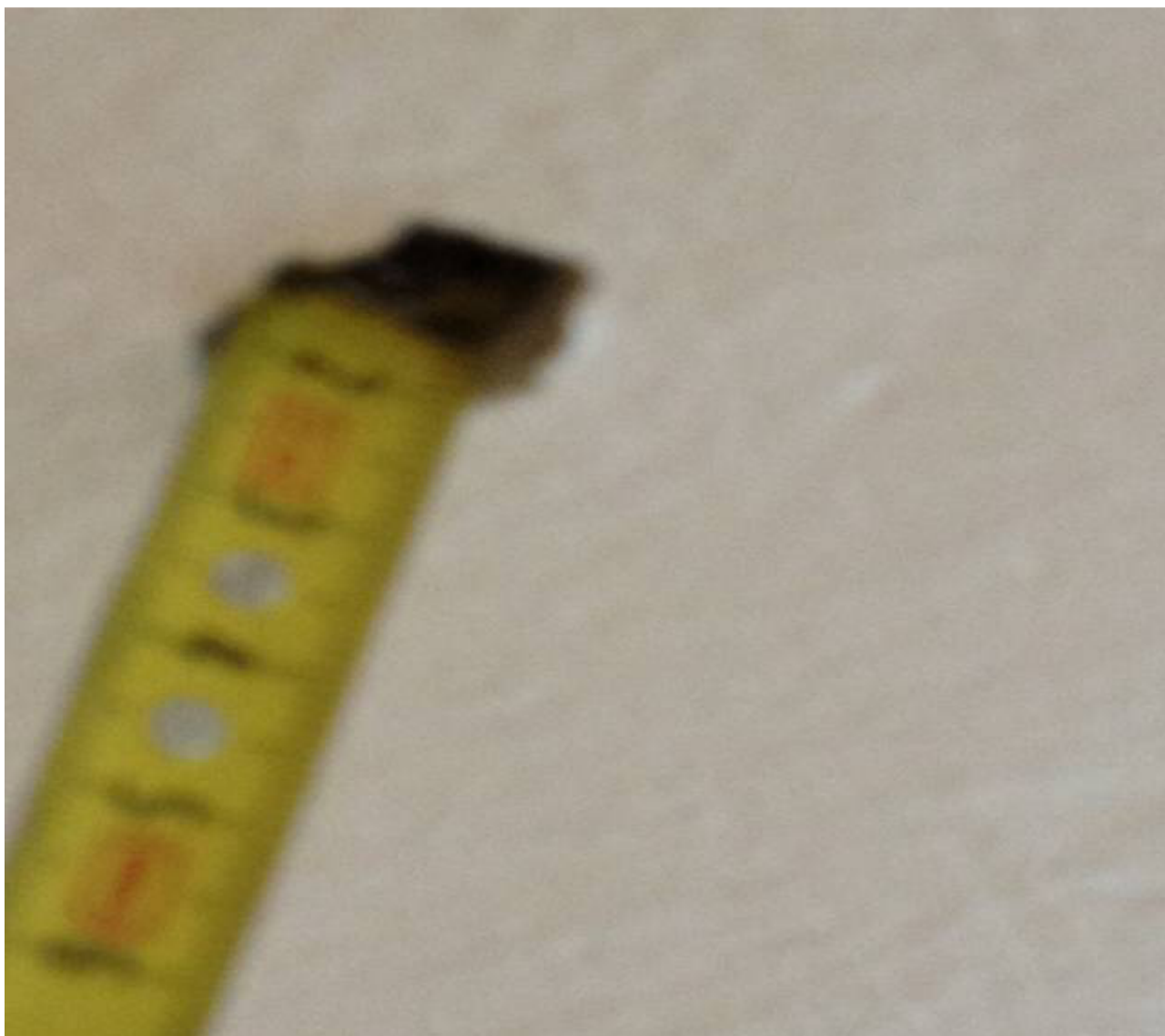
FOTO 10) Rif.to n.5 - nelle planimetrie B e C allegate PALESTRA: SOLETTA (tra i travi di copertura) - RICOPRIMENTO CM 2
