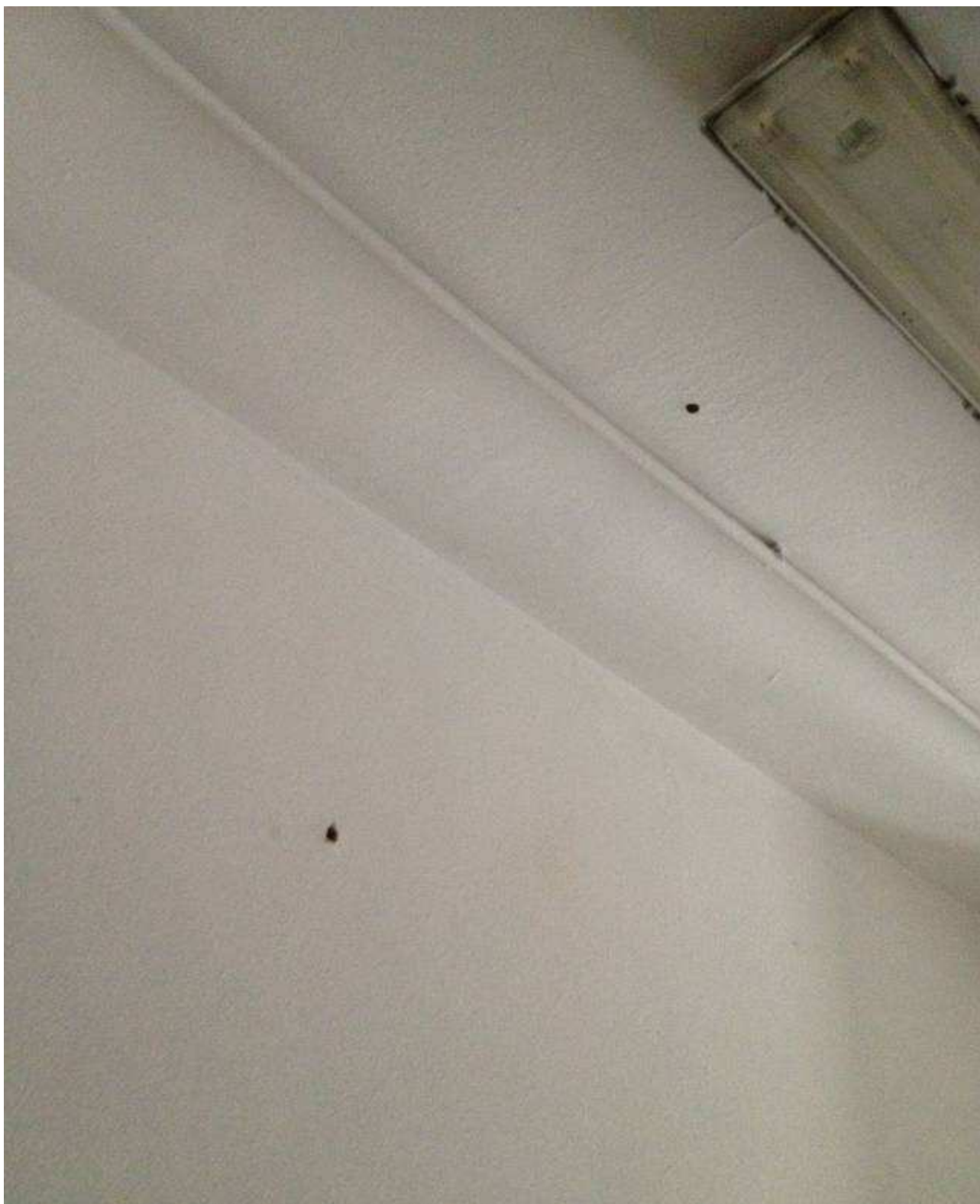
FOTO 13 ) Rif.to n. 7 - 8 nella planimetria A - allegata SONDAGGI SU MURO E SOLAIO SEPARAZIONE SCALA/TEATRO al 2°piano seminterrato, 2 cm intonaco a ricoprimento del laterizio in entrambi i punti
