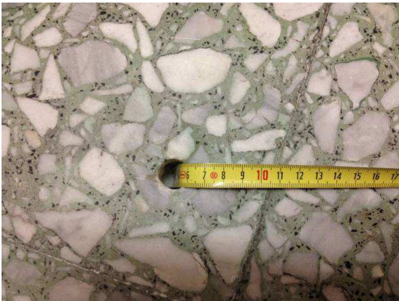
FOTO 15) Rif.to n.11 - nella planimetria B allegata PIANO 1°SEMINTERRATO - sondaggi su orizzontamento tra ufficio teatro e locale spogliatoio/mensa scuola; cm 5,5 di sottofondo compresa la piastrella di pavimento, alla struttura in c.a.
