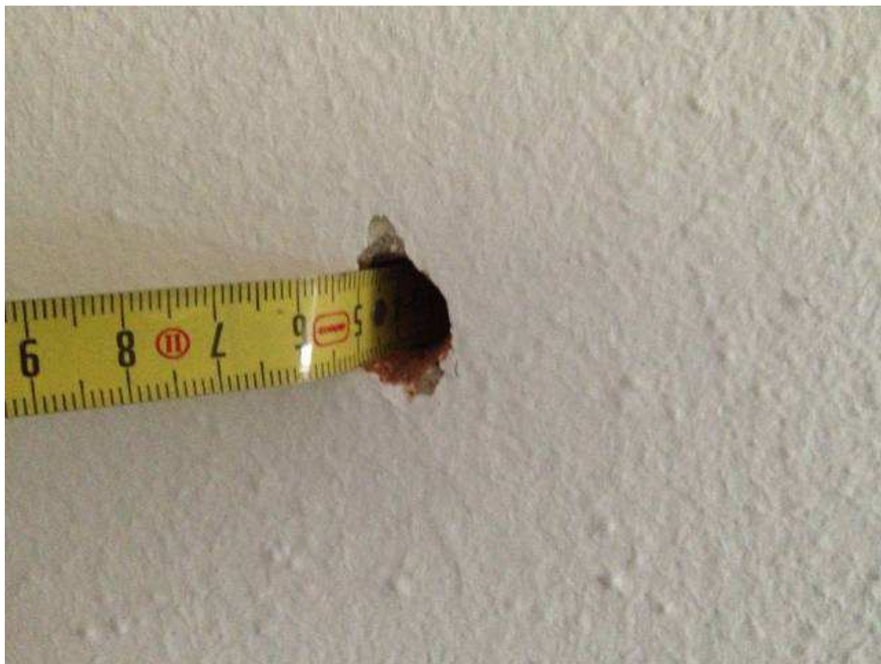
FOTO 12) Rif.to n.7 - nella planimetria A - allegata MURO DI SEPARAZIONE SCALA SCUOLA/TEATRO al 2° piano seminterrato, 2 cm intonaco su muratura in mattoni (non è stato possibile misurare lo spessore della parete)
