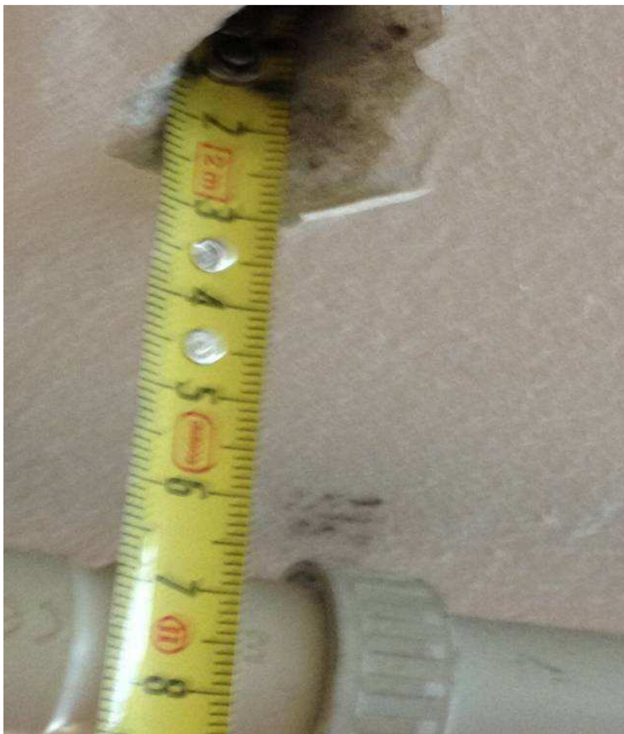
FOTO 11 ) Rif.to n.6 - nelle planimetrie B e C allegate PALESTRA: SOLAIO DI COPERTURA - RICOPRIMENTO SOTTOTRAVE CM 2
