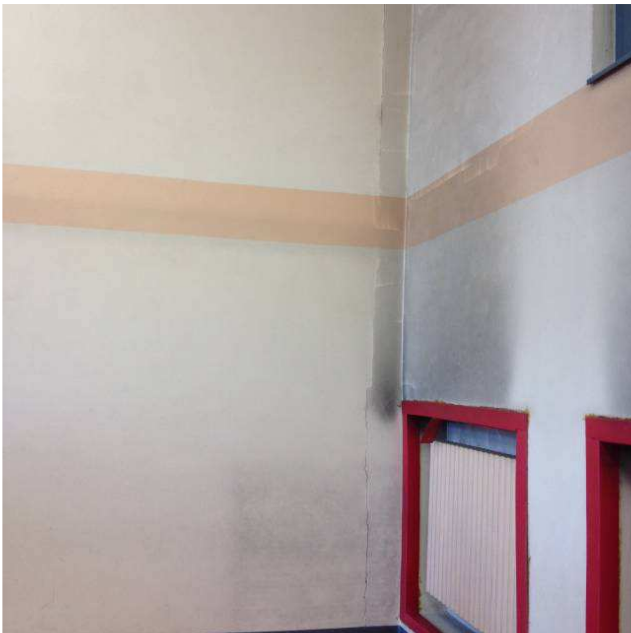
FOTO 7) PALESTRA: MURO DI SEPARAZIONE CON IL TEATRO MATTEOTTI - DISTACCHI TRA I COMPONENTI costituiti da materiali differenti (muratura in blocchi Ytong/pilastro c.a.)
