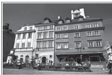
Edifici addossati ma distinti
