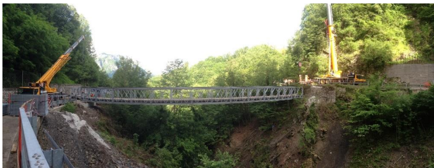
Ponte carrabile a una corsia per viabilità provvisoria - Val Taleggio (Bergamo)
