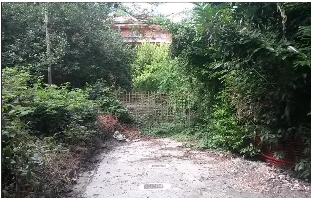
**Figura 18** – Pozzetti carrabili con chiusini in ghisa a protezione di In3-3 e Pz3-3.
