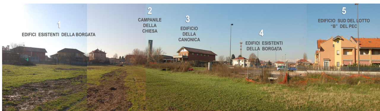
RIPRESA PANORAMICA DAL CONFINE NORD DELL'AREA IN OGGETTO
