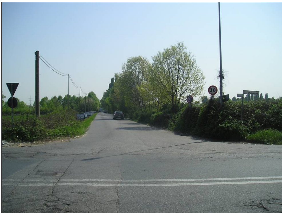
Figura 3.2/4 - Via Scarrone nell'innesto con via Debouché
