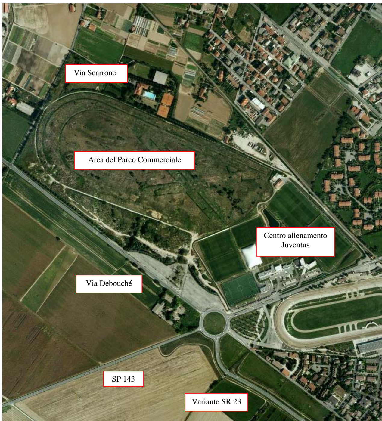
Figura 1/2 L'area del Parco Commerciale con il limitrofo Centro Allenamento Juventus
