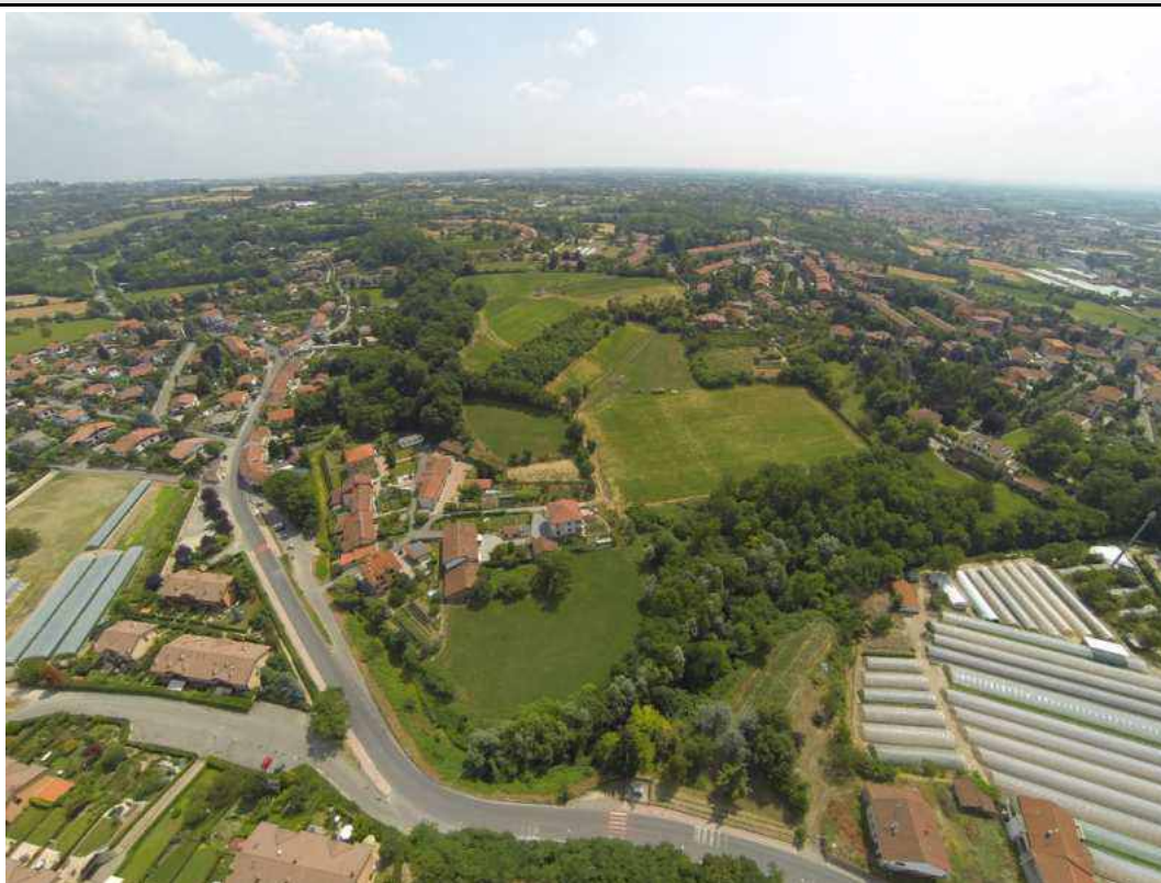
Vista n. 4 – L'ambito oggetto di PEC visto da nord-ovest
